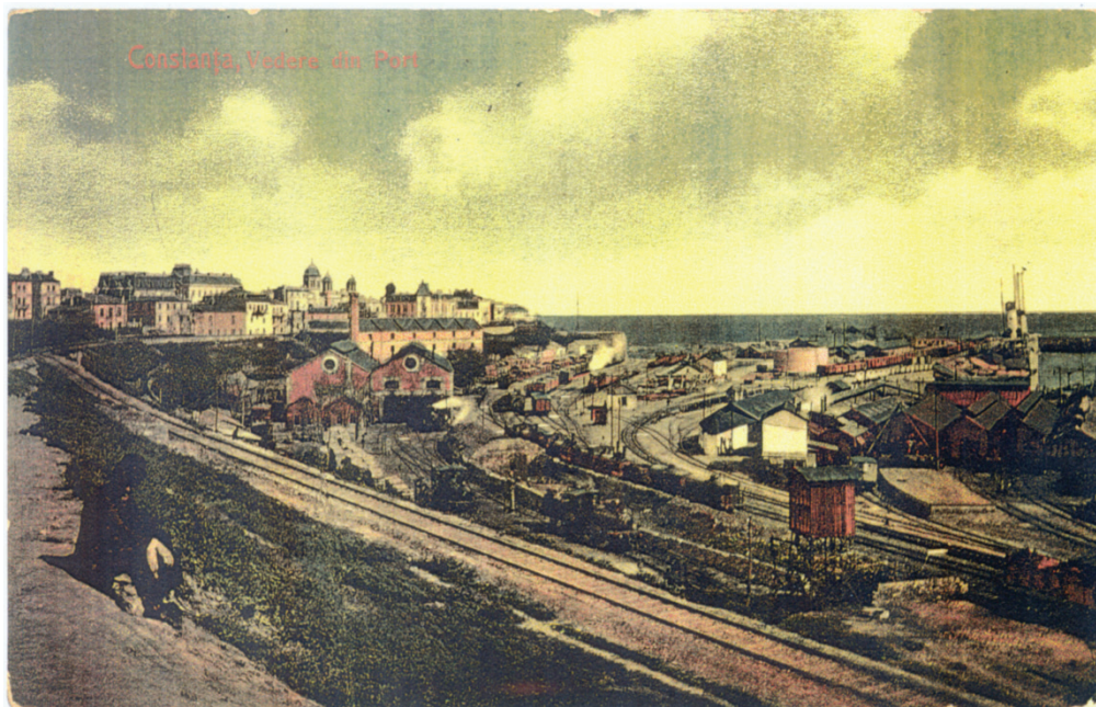
Fig. 15. Vedere pe care este surprinsă zona sub care se conservau ruinele Edificiului cu mozaic.
