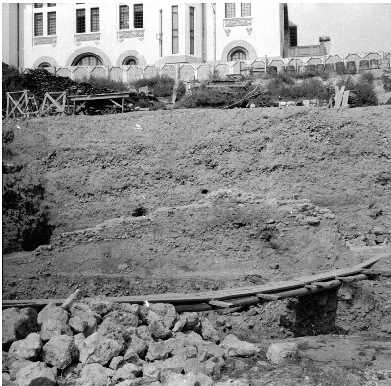
Fig. 20. Zidul modern ridicat peste ruinele B11 (Arhiva fotografică MINAC, cl. nr. 1816).
