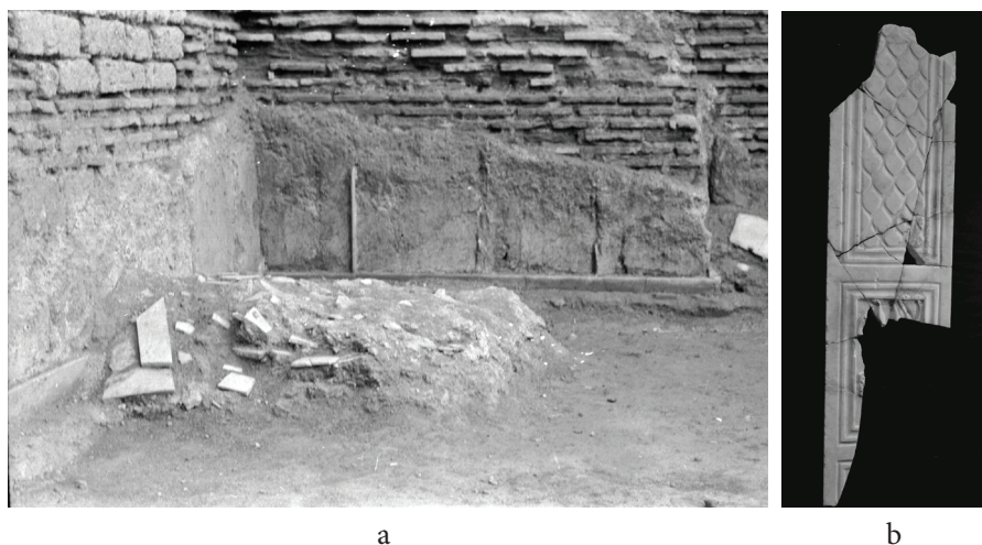
Fig. 81. a) Ampretele placajului cu marmură în mortarul din colțul de est al terasei superioare (Arhiva fotografică MINAC, cl. nr. 1140/2); b) Placă din marmură cu trei registre descoperită la baza zidului de SV al terasei superioare (Arhiva fotografică MINAC, cl. nr. 6959)
