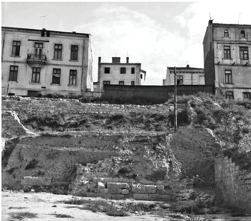
Fig. 89. Zona C4-C5 înainte de deschiderea secțiunilor (Arhiva fotografică MINAC, cl. nr. 10942)
