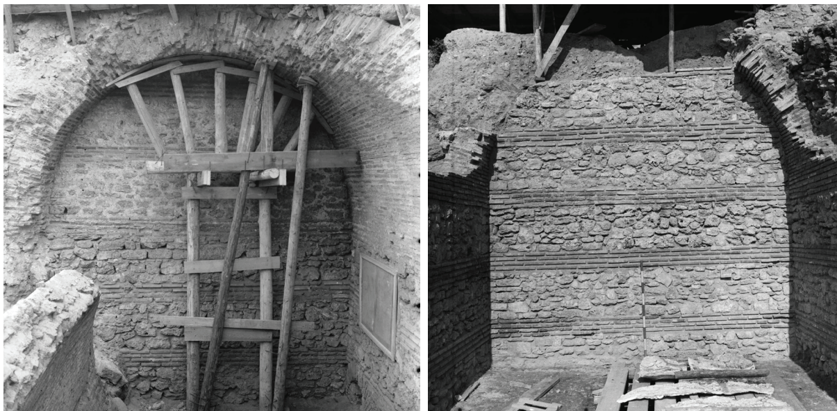
Fig. 41. a) zidul timpan în B1, se observă diferența de material litic folosit în primele trei benzi de piatră de jos, față de ultimele două din partea de sus (Arhiva fotografică MINAC, cl. nr. 6025); b) zidul timpan în B5 (Arhiva fotografică MINAC, cl. nr. 1799)
