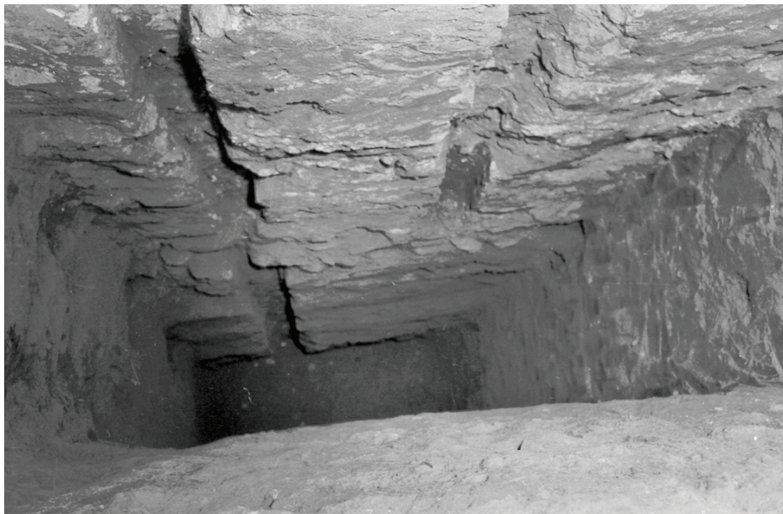
Fig. 31. Secțiune la baza zidului de nord-est al mării săli cu mozaic; detaliu de fundație (Arhiva fotografică MINAC, cl. nr. 1738).
