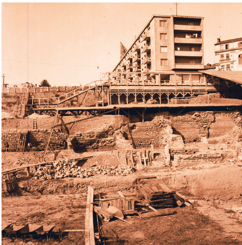
Fig. 60. Vedere generală asupra nivelului median al Edificiului cu mozaic: de la încăperea cel mai bine conservată, la cea păstrată cel mai precar B3, B4, B5, B6, B7 și parțial B8; pe profilul din spatele B6, 7 și 8 se vede cum coboară stratul de intervenții moderne (Arhiva fotografică MINAC, cl. nr. 1777).
