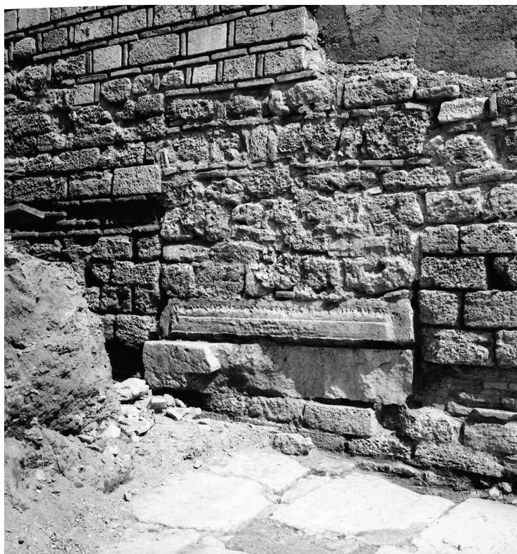
Fig. 68. Intrarea în B12 zidită în același moment în care partea de sud-vest a zidului de nord-vest a fost refăcută (Arhiva fotografică MINAC, cl. nr. 9272).
