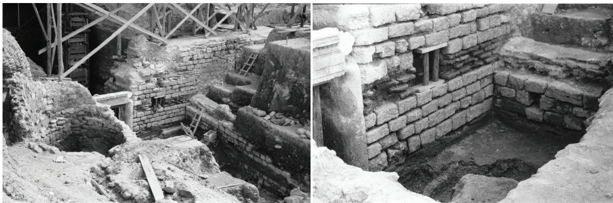
Fig. 40. a) Zidul de susținere a treptelor (Arhiva fotografică MINAC, cl. nr. 872/1); b) detaliu al modului în care zidul se sprijină pe fața celui de sud-vest al terasei mijlocii (Arhiva fotografică MINAC, cl. nr. 1214).
