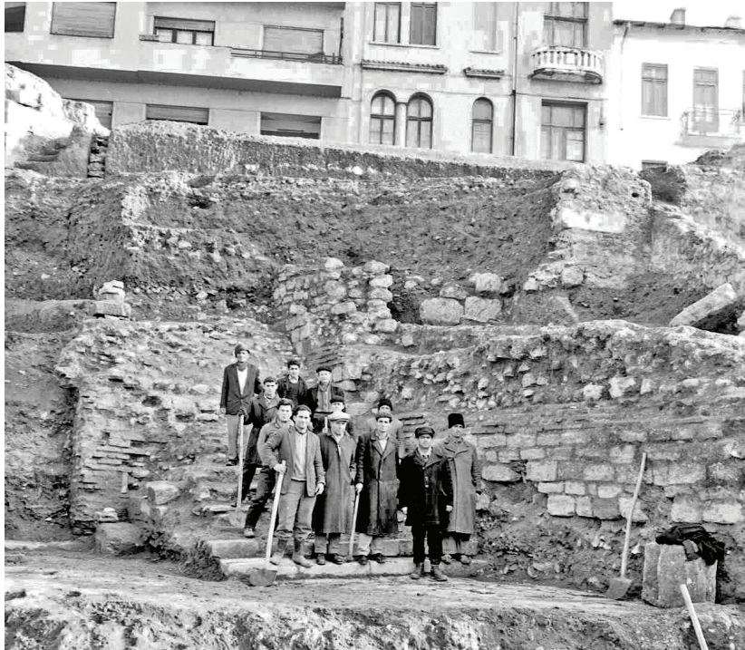
Fig. 13. Treptele care făceau legătura între Edificiul cu lentiaron și oraș (Arhiva fotografică MINAC, cl. nr. 6814).
