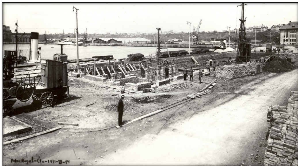
Fotografie ce ilustrează perioada de debut a construcției Gării Maritime Constanța
