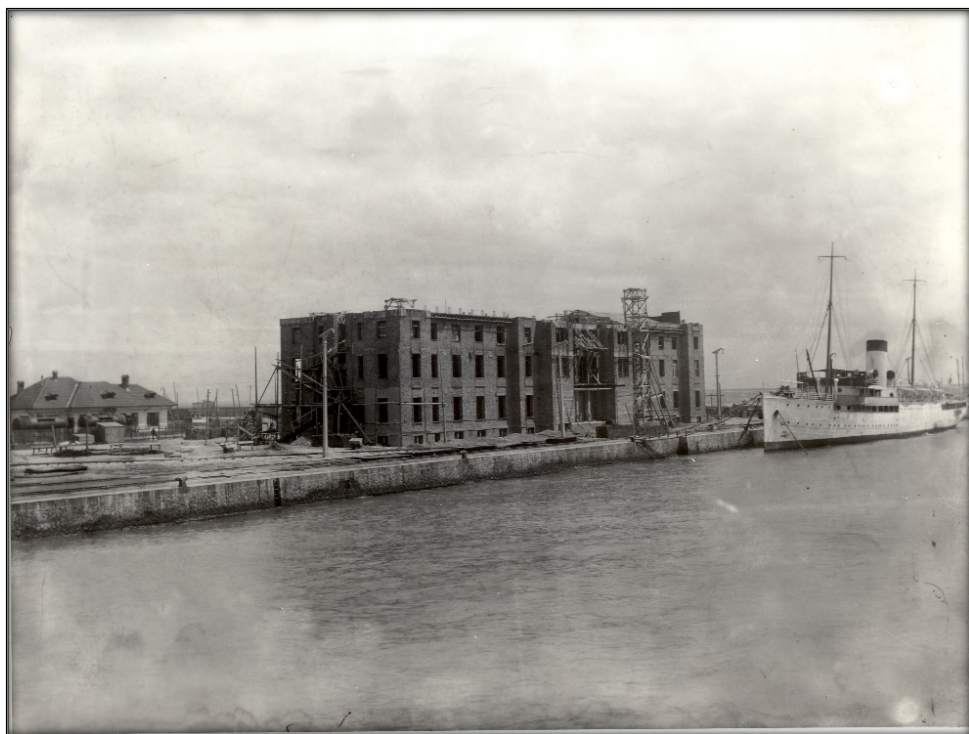
Fotografii ce ilustrează diferitele etape de construcție a Gării Maritime Constanța
